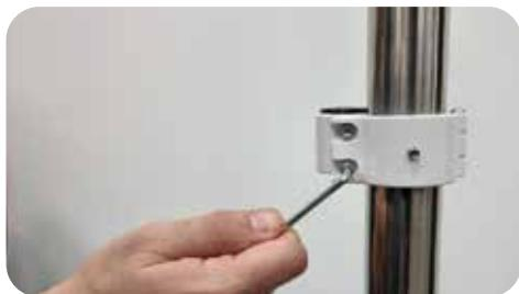
2. Dotiahnite dorazovú/bezpečnostnú skrutku 3mm inbusovým kľúčom (je súčasťou balenia).
